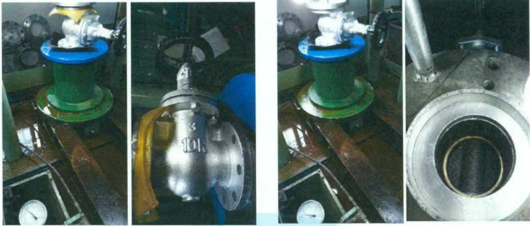
照片 25 法蘭口鑄鐵閘閥 10K (F05 3吋) 閥體及閥座試驗實況
