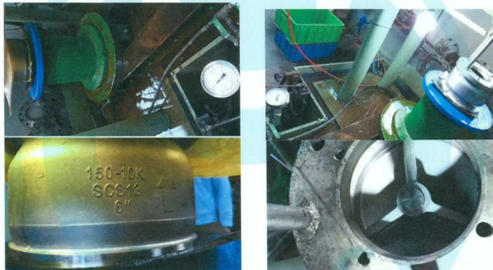
照片 14 夾式不銹鋼緩衝逆止閥 10K (S37 6吋) 閥體及閥座試驗實況
