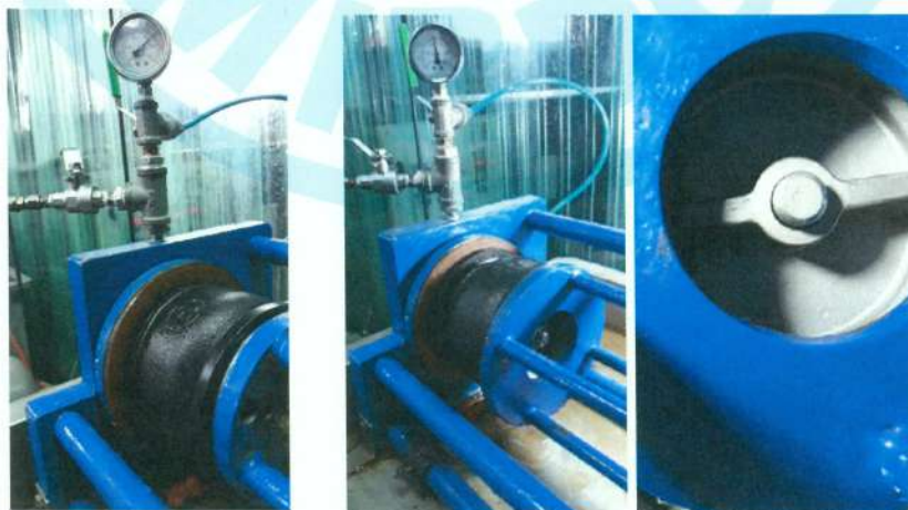
照片 36 夾式延性鑄鐵緩衝逆止閥 16K (D39 4吋) 閥體及閥座試驗實況
